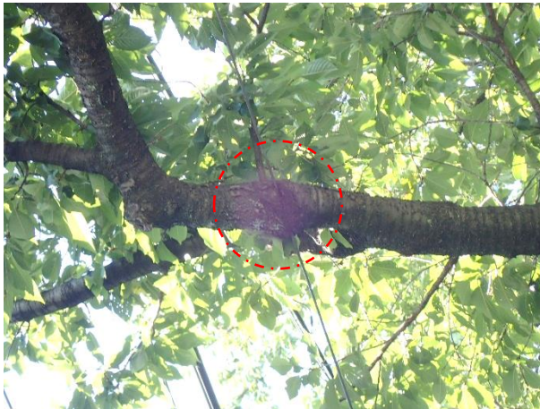
①線を飲み込んでいる枝（車道側、○内）
