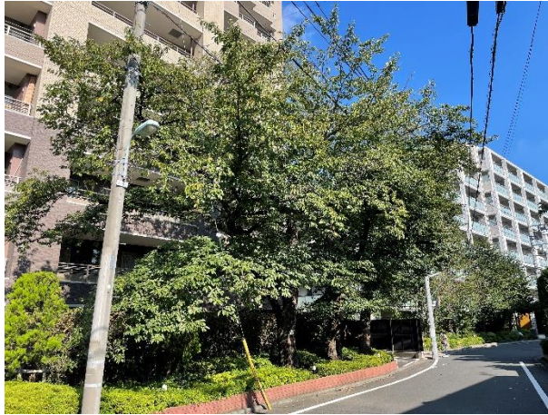
C～E の全景写真 南西面
