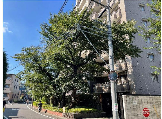
C～E（手前が E）の全景写真 南東面
