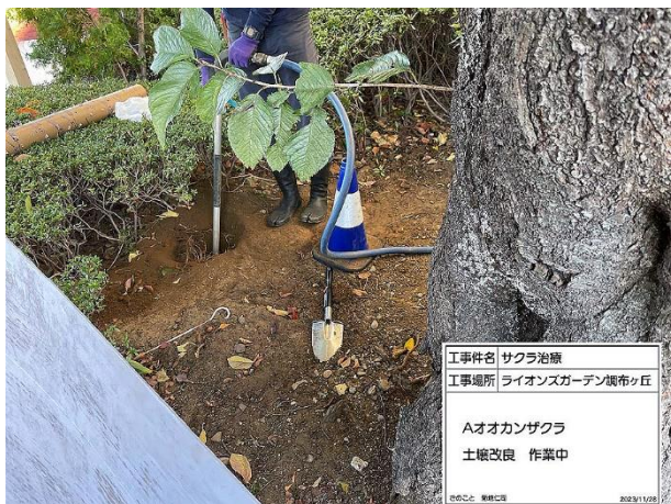
A 土壌改良 作業中（坪穴）
