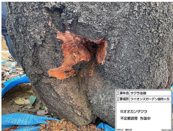
B 不定根誘導 作業中（コフキタケ、樹皮除去）
