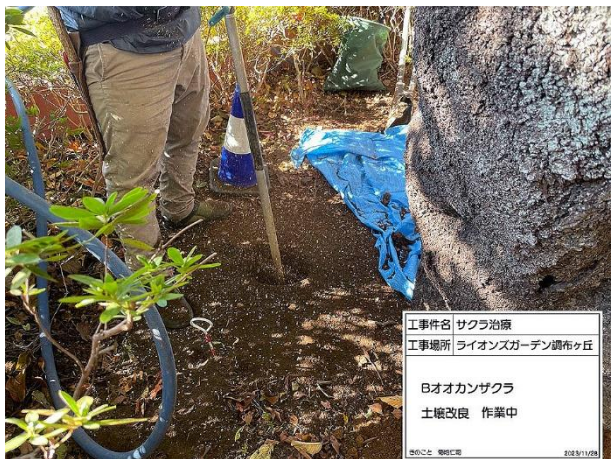
B 土壌改良 作業中
