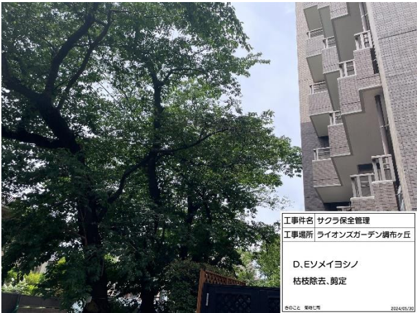
D、E 剪定、枯枝除去 作業前
