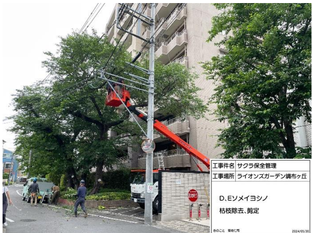
D、E 枯枝の除去、剪定 作業中
