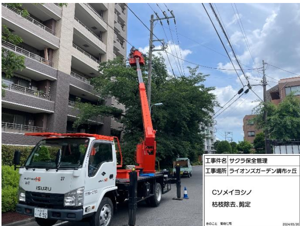
C 枯枝の除去、剪定 作業中
