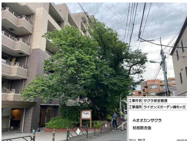
A 枯枝の除去、剪定 作業後
