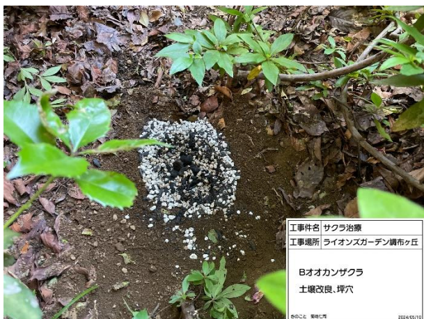
B 土壌改良 作業中（坪穴）
