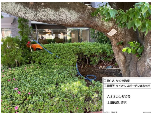
A 土壌改良 作業中
