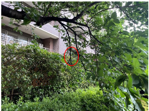
A 取り木試験施工 作業後
