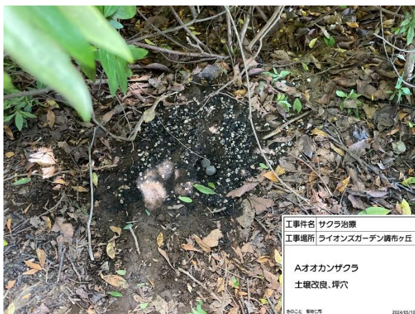
A 土壌改良 作業中（坪穴）
