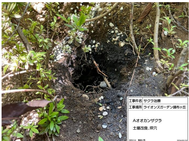
A 土壌改良 作業中（坪穴）
