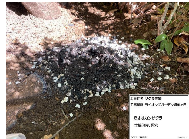
B 土壌改良 作業中（坪穴）
