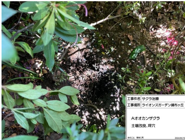
A 土壌改良 作業中（坪穴）
