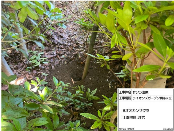
B 土壌改良 作業中（坪穴）
